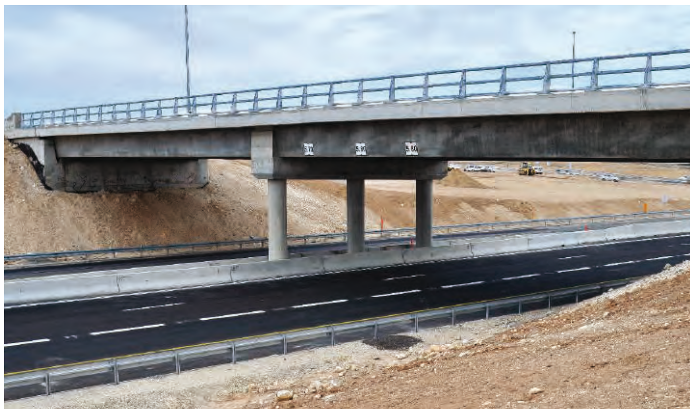
כביש 31 לערד. המעקף סביב הגשר בוצע עם יחידת פיצול בכניסה וביציאה של קו המעקות. דגם: DB100S/6M
