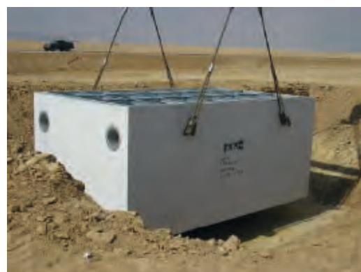
התקנת מפריד דלקים ושומנים מינרליים 303-cmos בנבטים.
