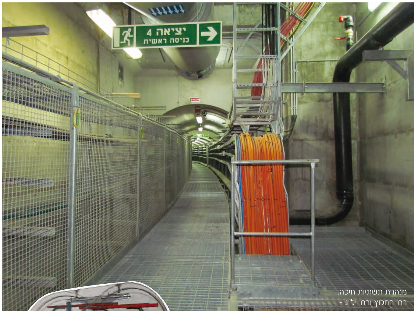
• ייצור ואספקת אלמנטים טרומיים לבניית מנהרות תשתיות. • תכנון, ייצור ואספקת כל האבזור הפנימי. • מבנה מנהרה בחתך עגול, מלבני או מבנה תעלה. • להתקנה בשיטת חפירה וכיסוי (Cut and Cover), או בדחיקה (Pipe Jacking).
